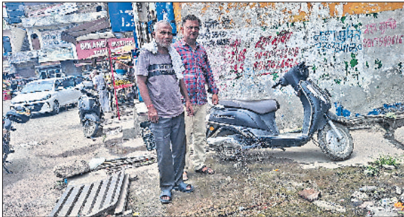
झज्जर। आंबेडकर चौक पर टूटे पेयजल सप्लाई के कनेक्शन दिखाते हुए लोग।
